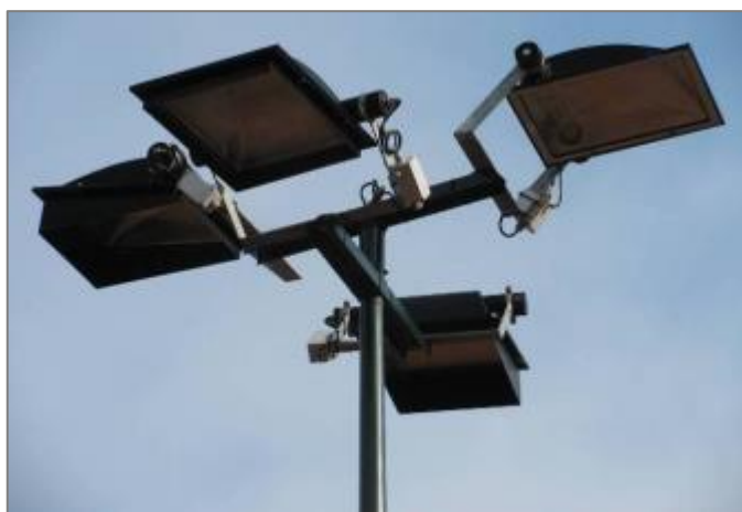
Figuur 7-1: Vleermuisvriendelijke verlichting, gedempt amberkleurig licht, aangepaste armaturen zonder lichtverstrooiing en toepassen op korte palen.
