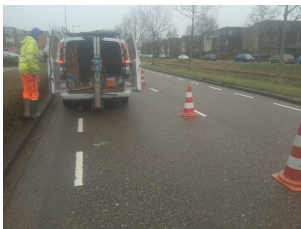
Fotonummer: 29 Omschrijving: Boring A018
