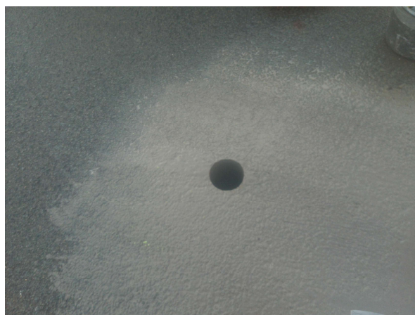
Fotonummer: 16 Omschrijving: Boring A008
