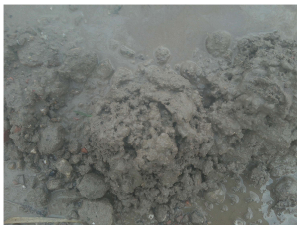
Fotonummer: 26 Omschrijving: Funderingsmateriaal A016
