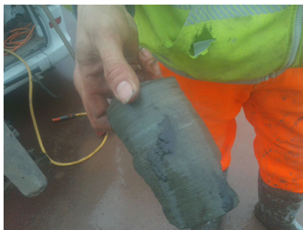
Fotonummer: 28 Omschrijving: Funderingsmateriaal A017
