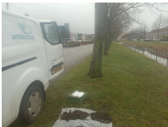
Fotonummer: 1 Omschrijving: Boring 014
