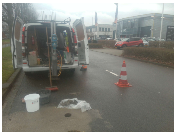
Fotonummer: 12 Omschrijving: Boring A005
