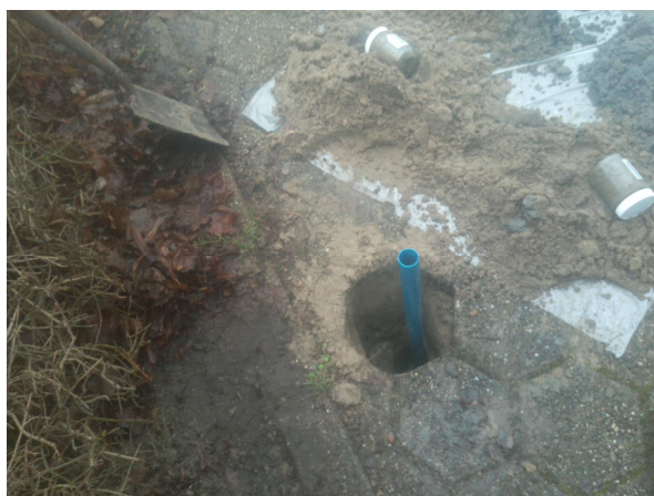
Fotonummer: 3 Omschrijving: Boring 016
