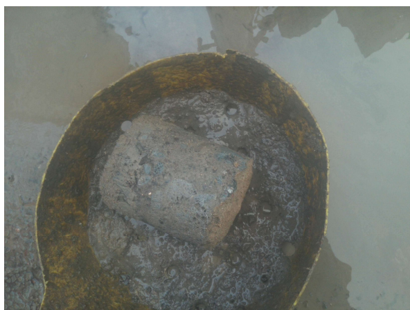
Fotonummer: 7 Omschrijving: Funderingsmateriaal A001
