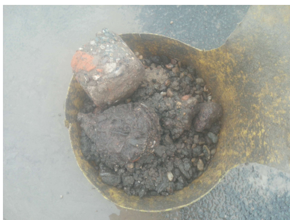
Fotonummer: 35 Omschrijving: Funderingsmateriaal A023
