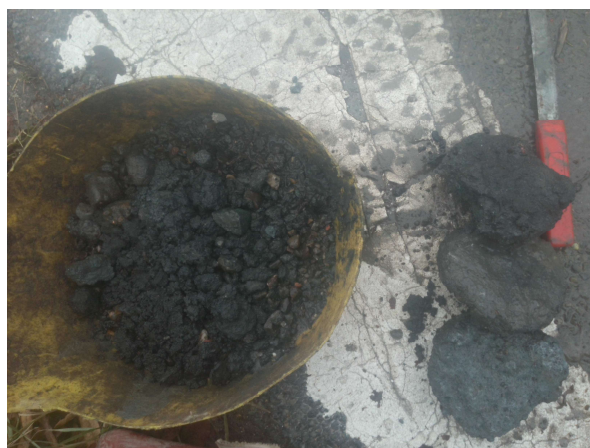
Fotonummer: 22 Omschrijving: Funderingsmateriaal A012
