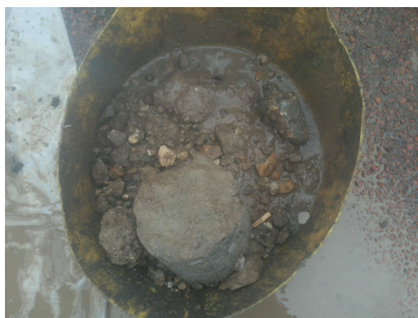
Fotonummer: 24 Omschrijving: Funderingsmateriaal A014
