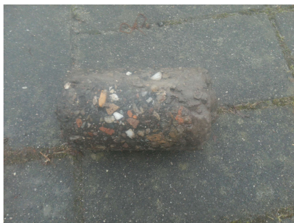
Fotonummer: 34 Omschrijving: Asfaltkern (0,36 – 0,53 m -mv)
