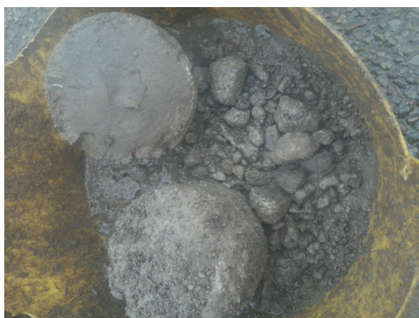
Fotonummer: 11 Omschrijving: Funderingsmateriaal A004
