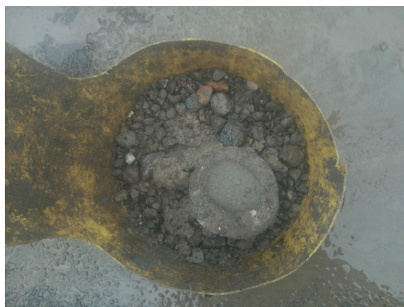
Fotonummer: 20 Omschrijving: Funderingsmateriaal A010
