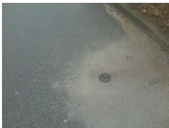
Fotonummer: 18 Omschrijving: Boring A009
