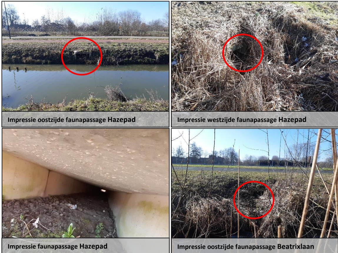
Figuur B: Impressie van de aanwezige faunapassages.
