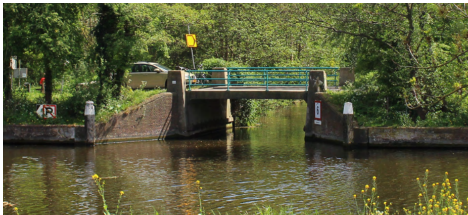
↑ HUIDIGE KNOTTERPOLDERBRUG ALS REFERENTIE VOOR DE NIEUW AAN TE LEGGEN BRUG, EIS 3.6.7.2.
