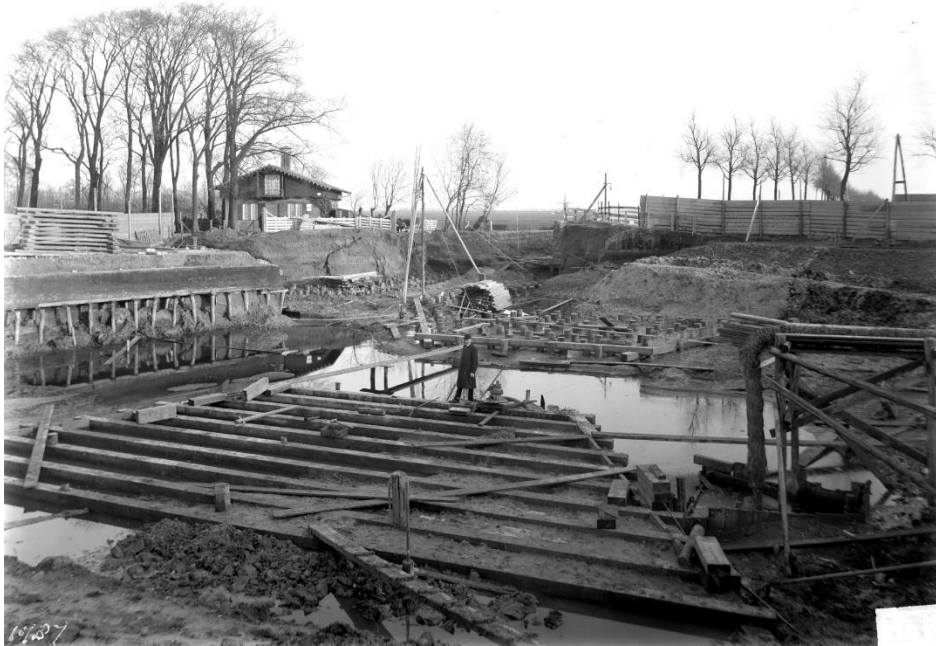
Figuur 8. De bouwkuip voor de bouw van de (eerste) Lammebrug in 1911. Op de achtergrond het Jagershuis dat ten opzichte van de polder erachter verhoogd ligt (bron: ELO, GN006325).
